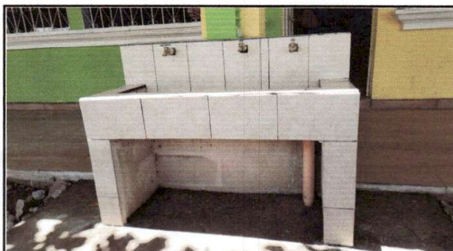
Foto 3: Sustitución de llave de chorro Instalación de azulejos en piletas de concreto
