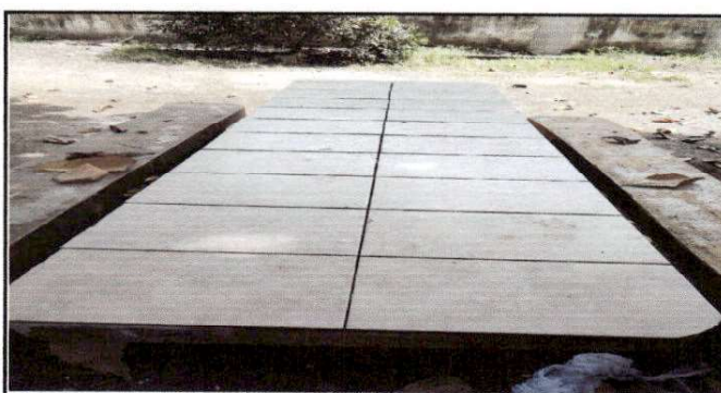
Foto 6: Instalación de azulejos en mesas de concreto
