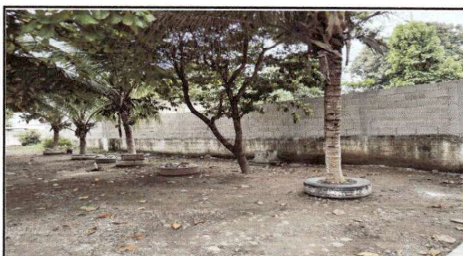
Foto 4: Reparación de muro perimetral de block
