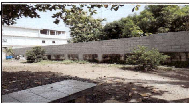
Foto 5: Reparación de muro perimetral de block
